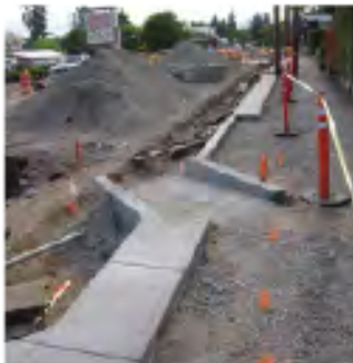
Mod. Gravel Layer
