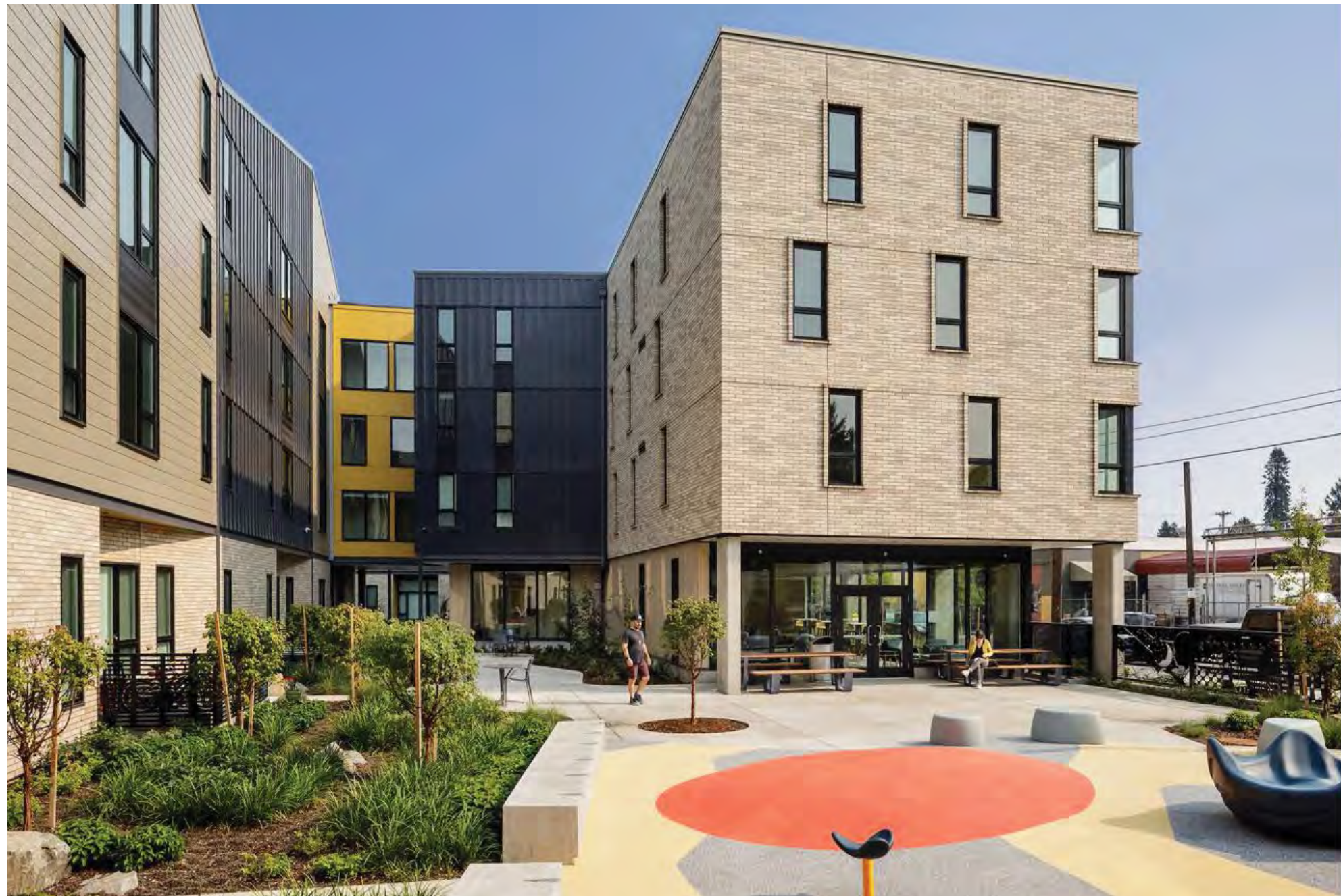
RENAISSANCE COMMONS APARTMENTS
