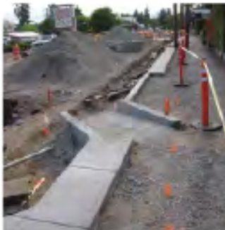
Mod. Gravel Layer
